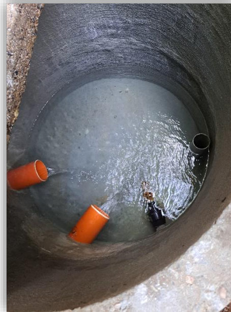
Po – zaústění jednotlivých zářezů do opravené šachty
