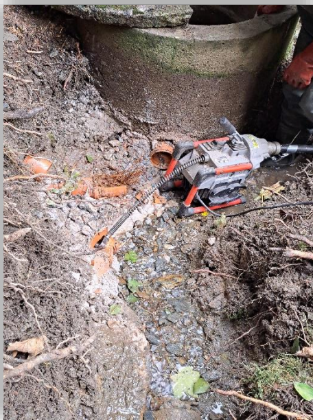
Při – strojní čištění zářezů
